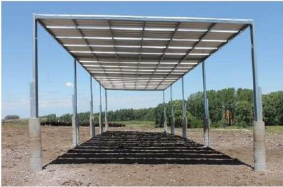
FIGURA 9. SOMBRA DE CHAPAS Y ESPACIO ENTRE LAS MISMAS PARA LOGRAR SECADO DEL PISO Y ELIMINAR CALOR
